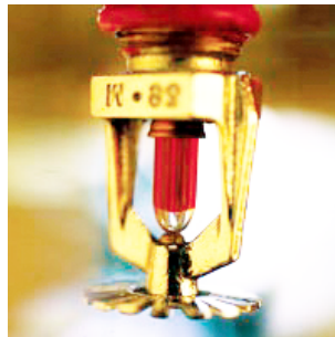
FIG. 2 – Le système "Sprinkler" repose sur ces ampoules qui éclatent sous l'effet de la chaleur.
